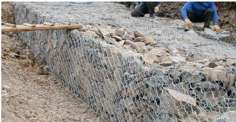
Figure 16 : mise en place d'un gabion
